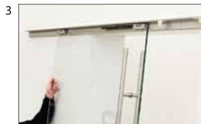
Einhängen des Türflügels in die Laufschiene von vorn
