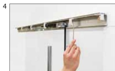
Montage der Clipsblendenhalterung mit demselben Innensechskantschlüssel
